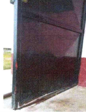
Foto 2: Se observa el deterioro de la pintura de las puertas
